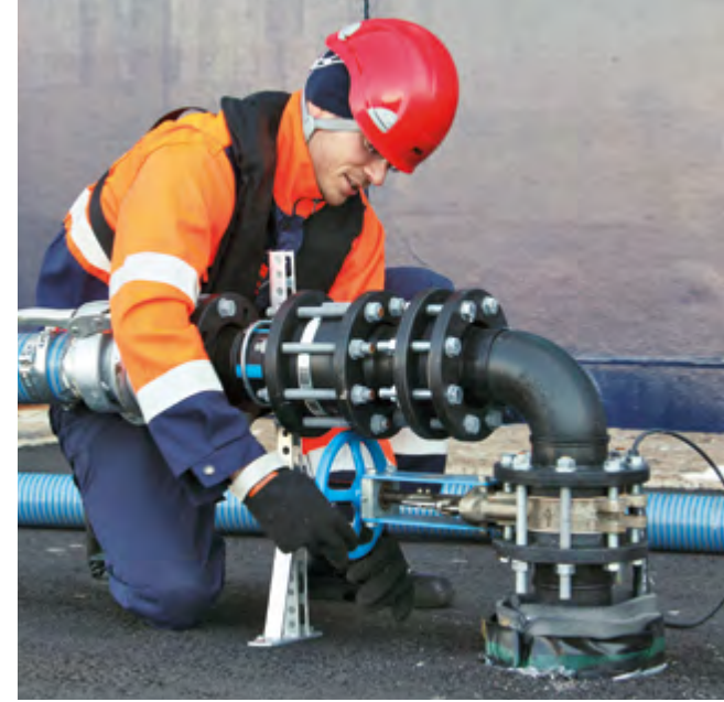
Kaikilla Helsingin Sataman laitureilla on vastaanottojärjestelmät alusten jätevesiä varten.
